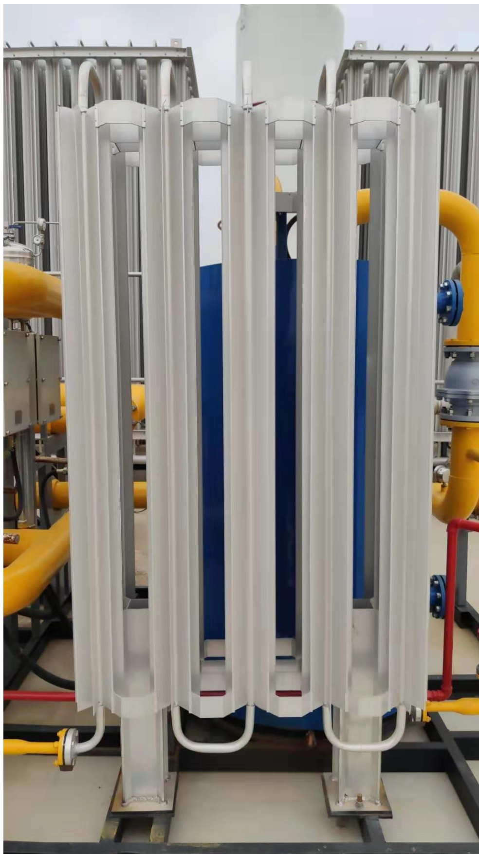
图 4-2 BOG 回收装置现场照片
