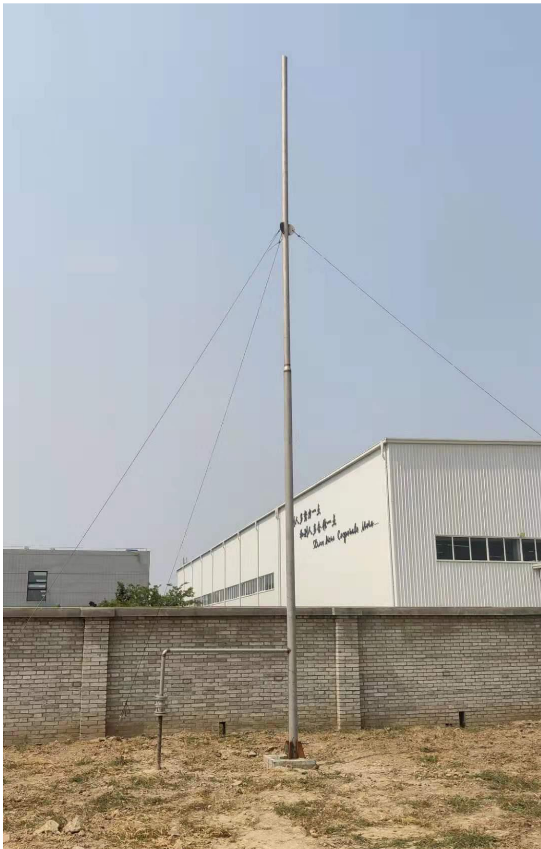
图 4-3 放散管现场照片
